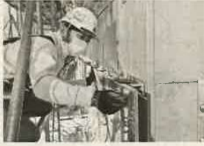
1階の外壁工事の様子
